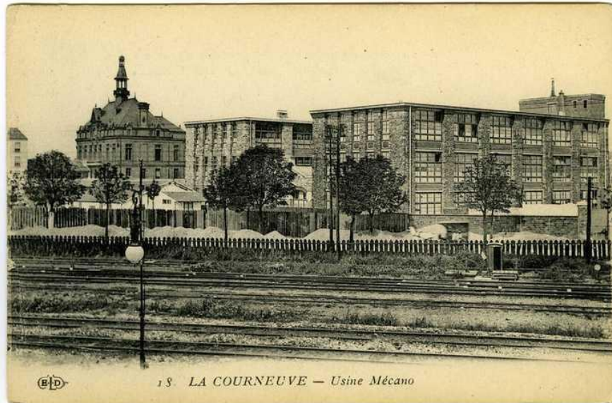
Usine Mécano , La Courneuve, carte postale, entre-deux-guerres, auteur non identifié (49 Fi 5319)
